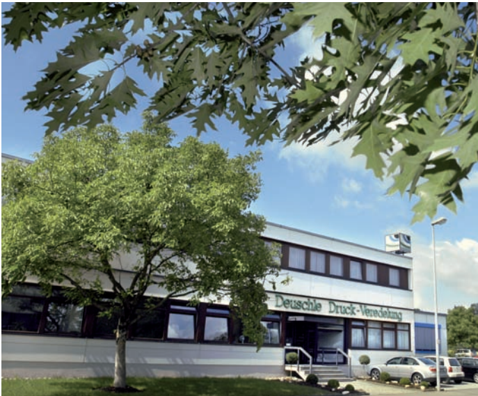
Außenansicht der Firma Deuschle Druckveredelung GmbH & Co. KG.
